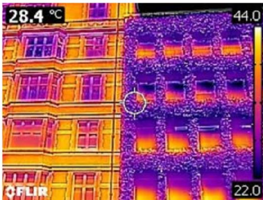
Figuur20: Thermografisch beeld van groengevel en "klassieke" niet-vergroende gevel. De temperatuur in de linkerbovenhoek is de temperatuur gemeten in het centrum van de foto (in dit geval dus op de groene gevel). Rechts in beeld staat de kleurschaal die van toepassing is op deze foto. Bron: Razzaghmanesh & Razzaghmanesh, 2017.
