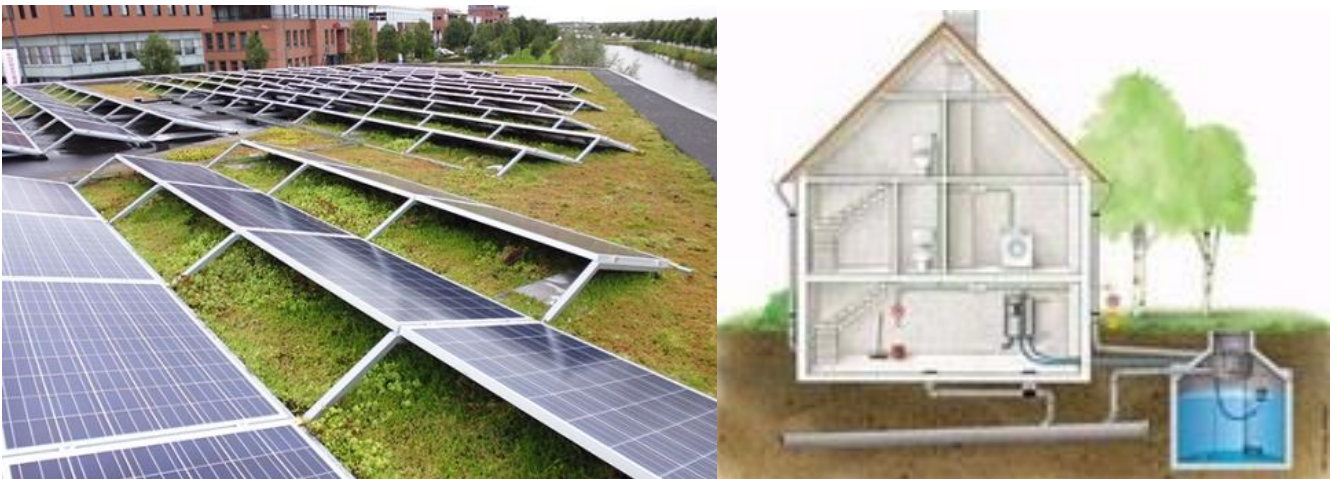
Figuur 29: Zonnepanelen op groendak ( https://www.mostertdewinter.nl/nl/groene-daken/xeroflor-solar-support/ ); Hemelwaterput ( https://www.vmm.be/water/bouwen/regenwater/hergebruik )
