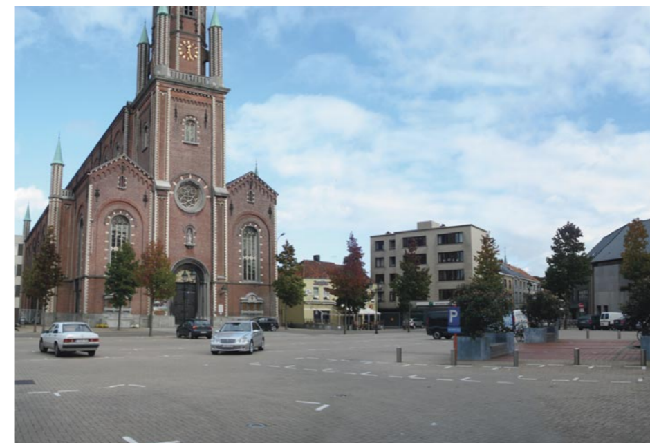
Ondergrondse regenwaterbuffer op de Markt.
